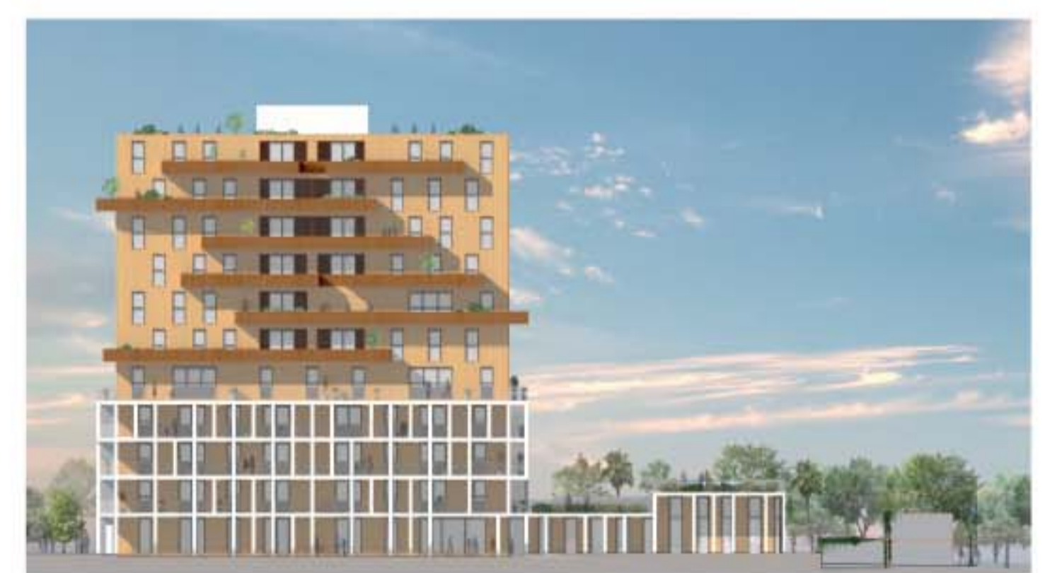
Façade Sud - Socle en béton et tour en bois
