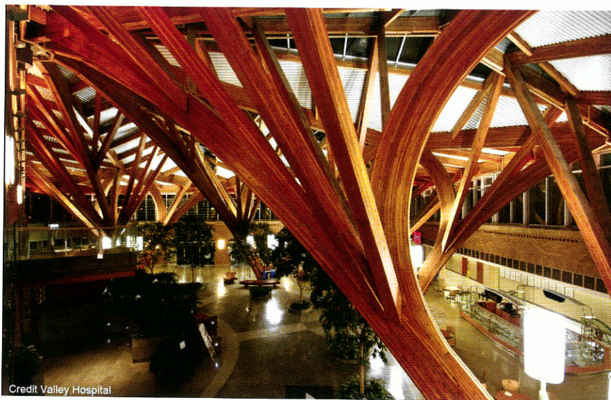
Fig. 5 : Exemple d'architecture bois dans un hôpital pour créer une atmosphère apaisante (Crédit photo Scott Norsworthy)
